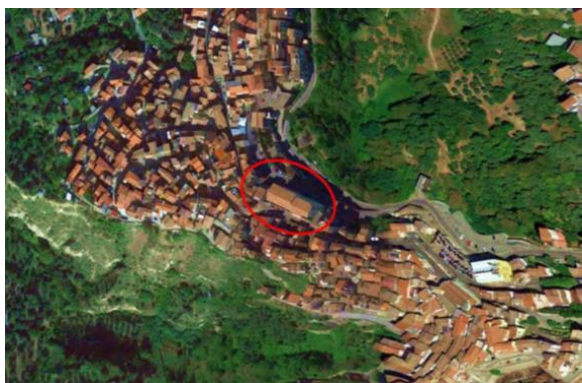
Figura 1 - Inquadramento territoriale dell'edificio
